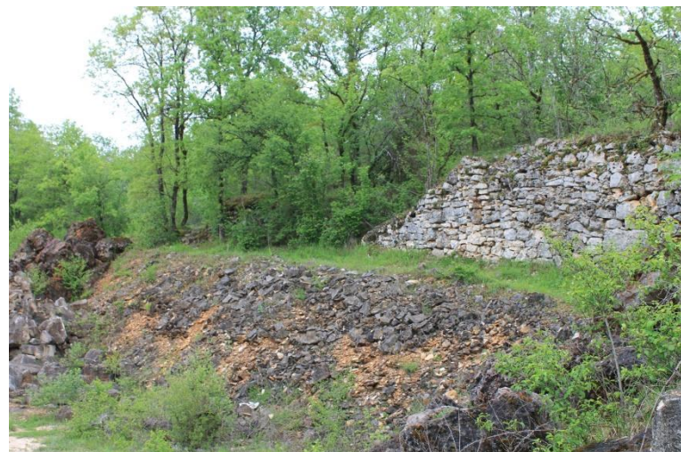
Passage du chemin rural en limite Sud-Est (vu depuis la carrière)
